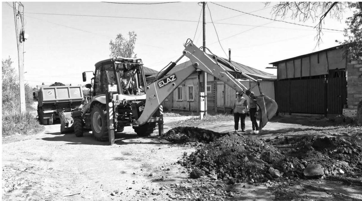
и прочистка водоотводных канав с последующим грейдированием с добавлением песчано-щебеночной смеси. Эти работы позволят снять вопрос подтопления домов – при условии, что жители тоже будут следить за канавой.
