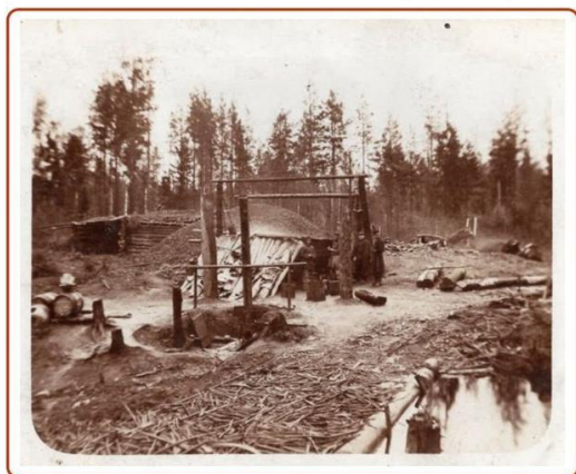
Строительство железной дороги на Ирбит от Екатеринбурга, 1914 г.
